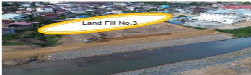
Land fill No.3 Section L-1 Km 0+750 to 0+900
