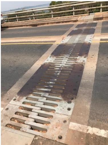
ຮູບທີ 3.2.1 (ຊ້າຍ) ຊ່ວງຫົດ-ຍຶດເພື່ອການຂະຫຍາຍຕົວ, (ຂວາ) ທໍ່ລະບາຍນ້ຳ
