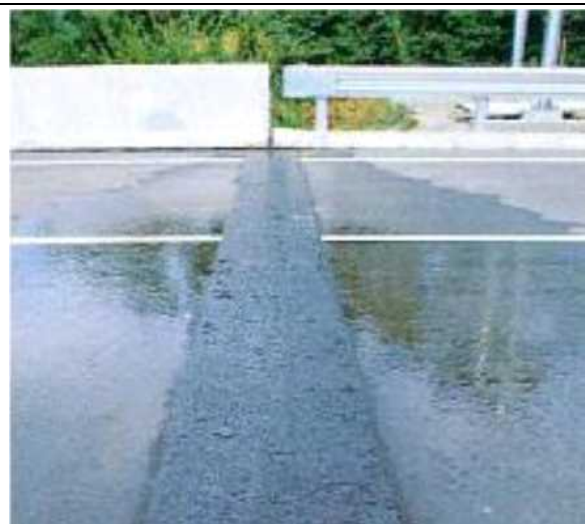
Flexible Asphalt pouring
